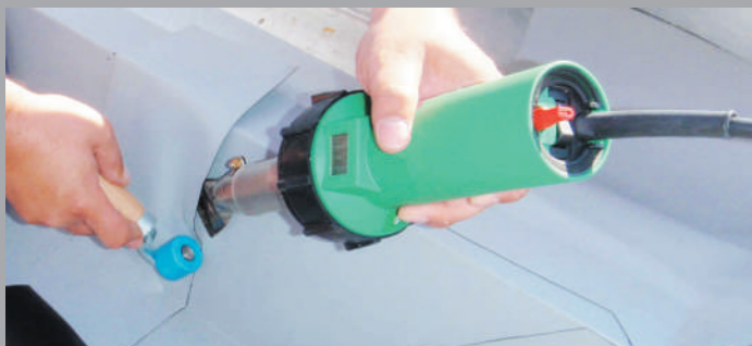
Сварка стыков водостока
