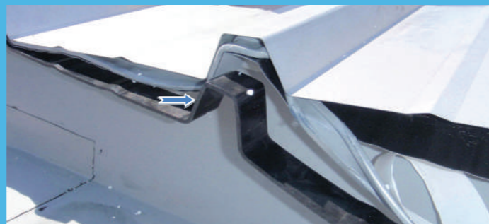
Герметик под панелью
