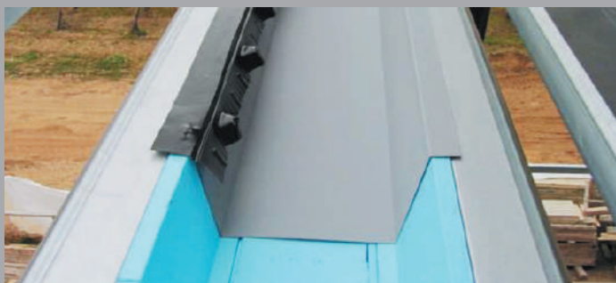
Установка теплоизоляции и основного желоба
