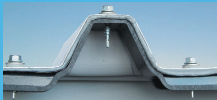
Крепление к кровельным панелям
